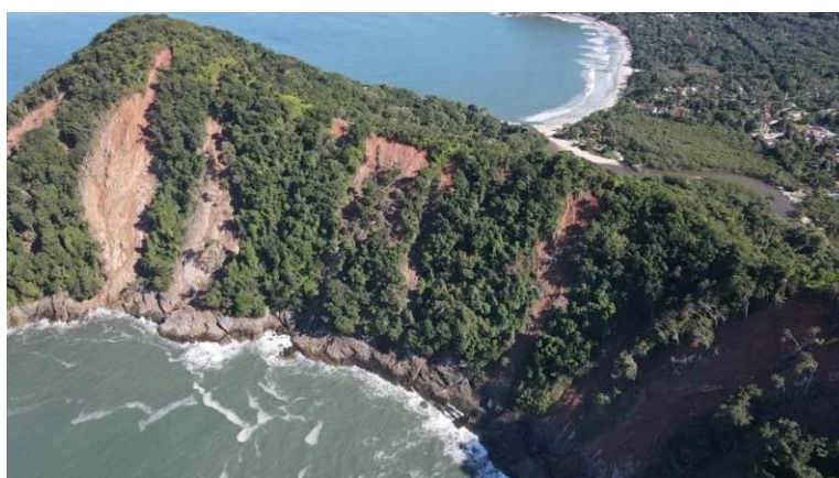
Figura 16. Escorregamento entre as praias da Baleia e Barra do Sahy - Fotos do Diagnóstico Ambiental do Projeto Restaura LN. Fonte: Atlântica, 2023.
